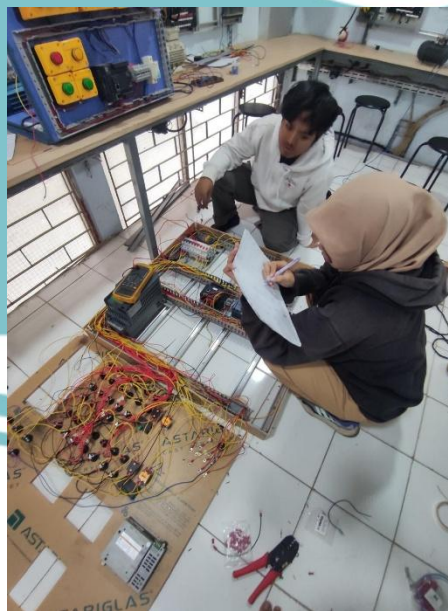
Lampiran 9 Proses pemasangan kerangka
