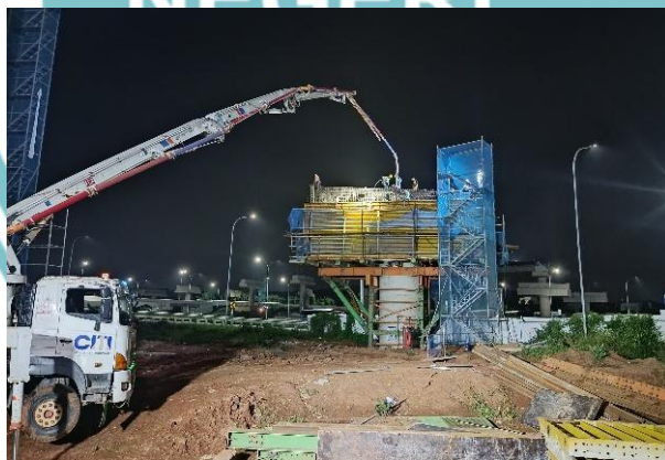
Gambar 4. 12 Pengecoran Pier Head P2 Tahap 1
