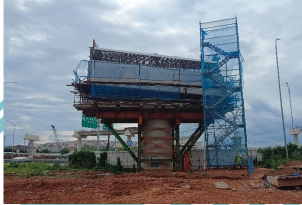
Gambar 4. 13 Pembongkaran Bekisting Pier Head P2 Tahap 1
