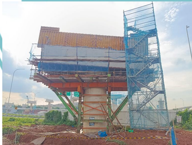
Gambar 4. 14 Pemasangan Bekisting Pier Head P2 Tahap 2
