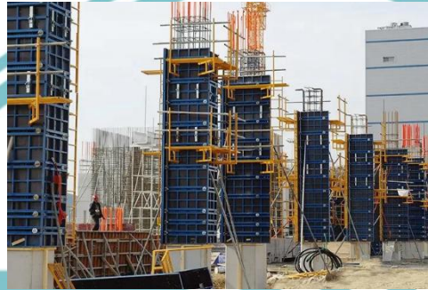
Gambar 2. 24 Bekisting Sistem Penuh
