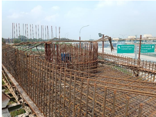
Gambar 4. 10 Pekerjaan Pembesian Pier Head P2
