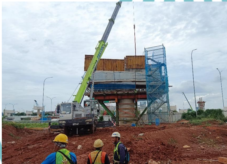
Gambar 4. 15 Pembongkaran Bekisting Pier Head Tahap 2
