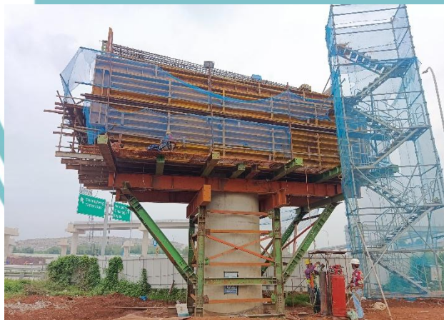
Gambar 4. 11 Pemasangan Bekisting Pier Head P2 Tahap 1
