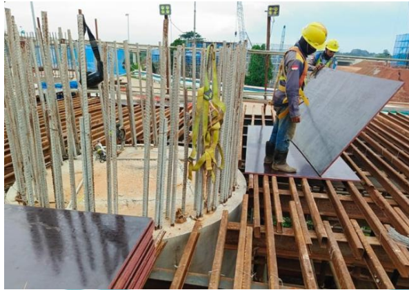
Gambar 4. 8 Pemasangan Bekisting Bawah Pier Head P2
