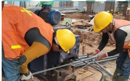
Gambar 2. 19 Pemotongan Tulangan dengan Bar Cutter
