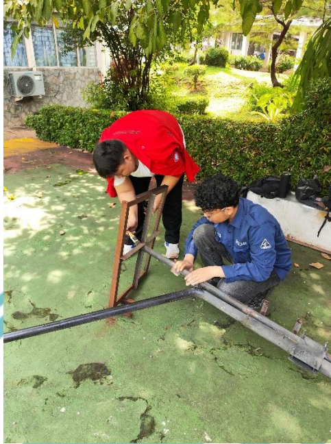
Lampiran 3 Proses pengamplasan tiang PJU
