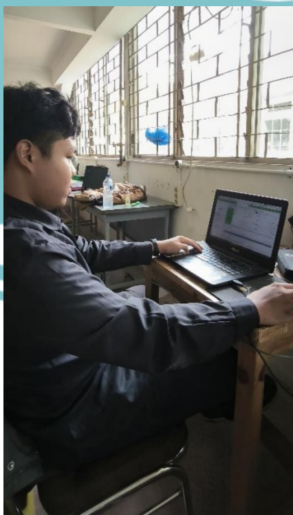
Dokumentasi 4 Proses pemrograman PLC dan pembuatan sistem SCADA
