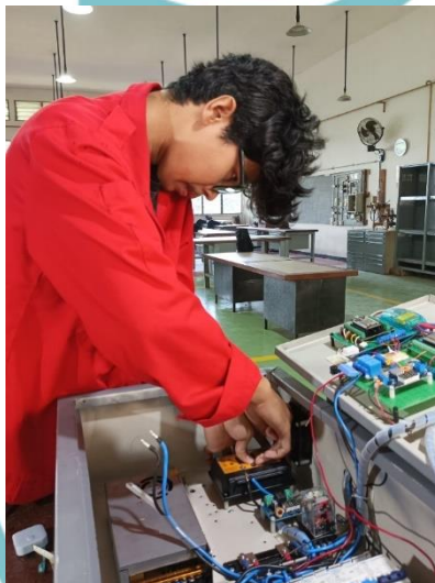
Proses Pemasangan dan Pengaturan Kontrol Charge
