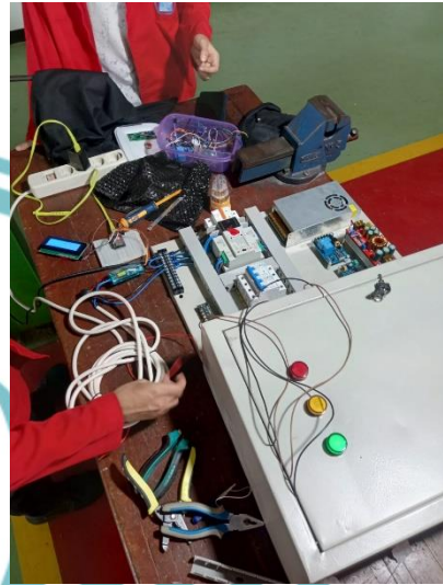
Proses Pemetaan dan Pemasangan Komponen UPS
