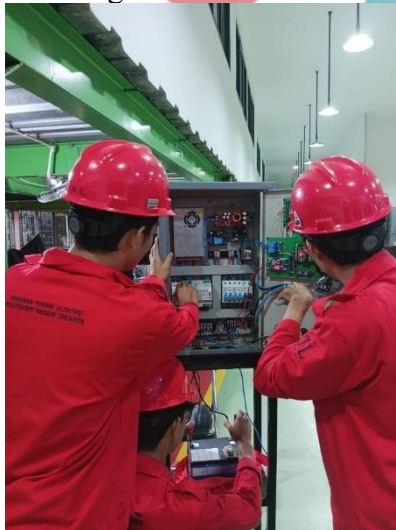
Proses Wiring Kontrol Sistem UPS
