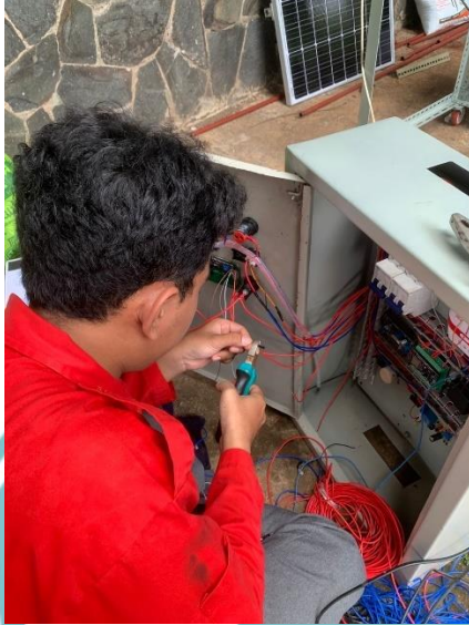
Dokumentasi pada saat wiring kabel
