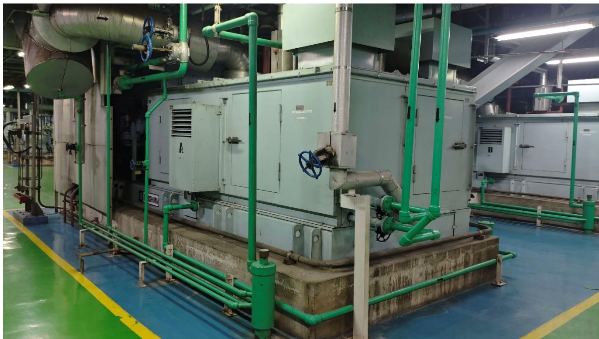
Lampiran 2.1 Dokumentasi motor listrik untuk HP/IP FWP dan nameplate nya
