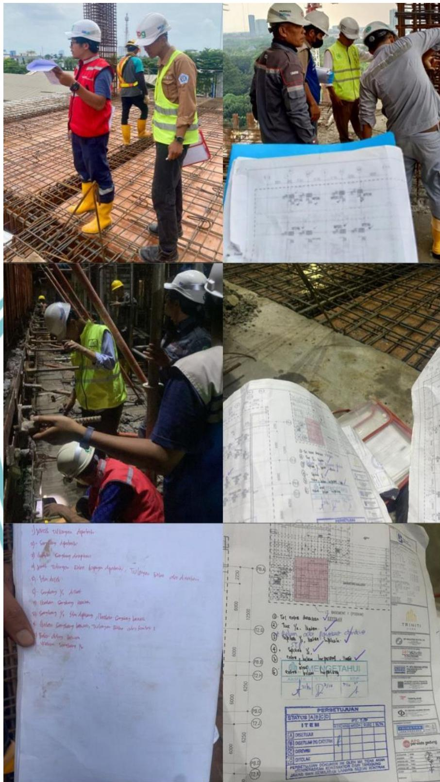
Gambar 4.19 Dokumentasi checklist pekerjaan struktur
