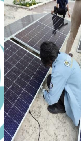
Proses instalasi PLTS atap di Gedung Grand Kemala Lagoon
