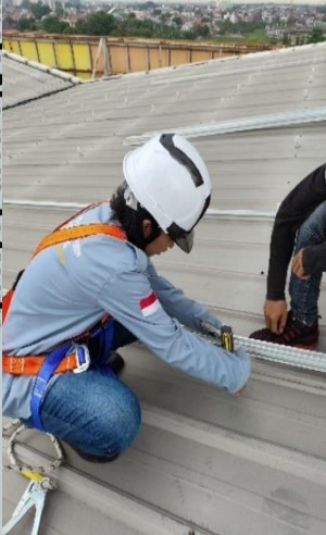
Proses instalasi PLTS atap di Gedung Grand Kemala Lagoon
