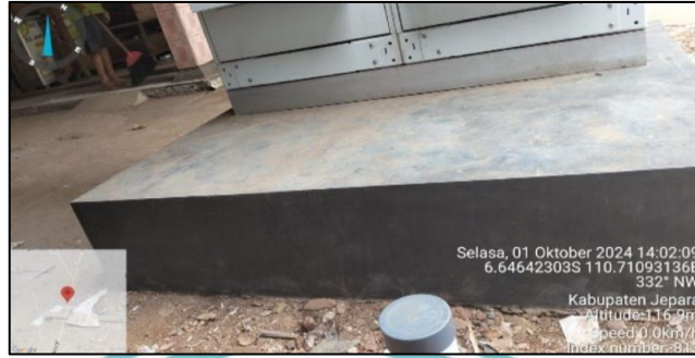
Gambar 2. 4 Contoh Pondasi Konvensional
