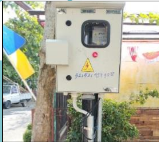
Gambar 2. 6 Contoh Instalasi kWh Box
