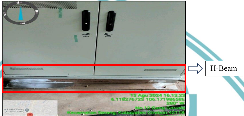
Gambar 3. 10 Pemasangan H-Beam Sumber: Dokumentasi PT Eka Mas Republik
