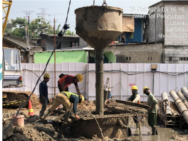
Gambar 3.12 pencabutan pipa tremie
