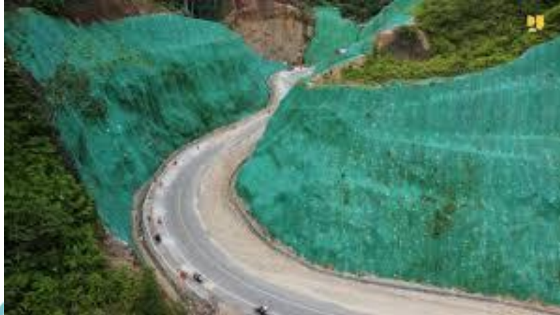
Gambar 2.9 Penanganan Lereng Ruas Rampa – Poriaha
