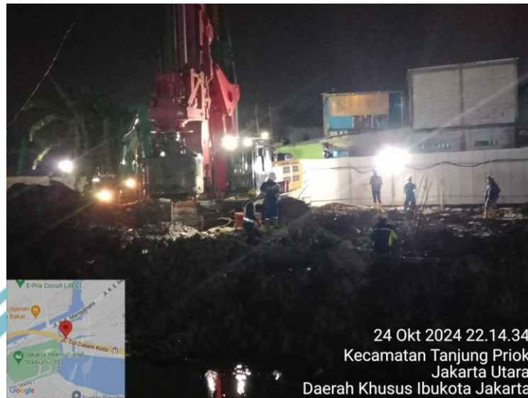
Gambar 3.7 pengisian lubang bor dengan polymer
