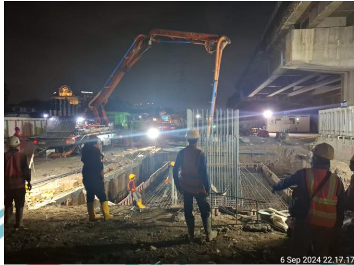
Gambar 3.20 pengecoran pile cap
