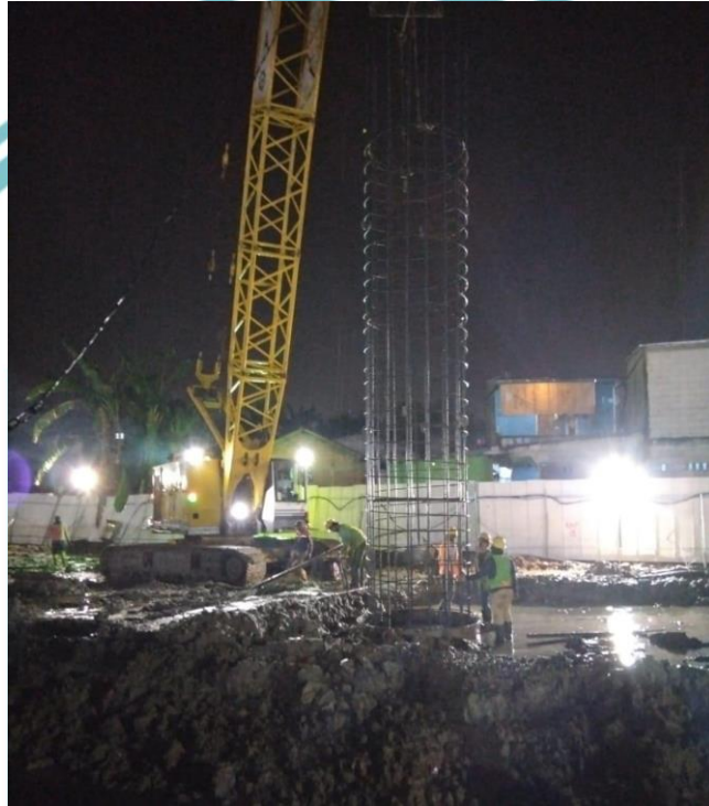
Gambar 3.9 Pemasangan Tulangan BorePile
