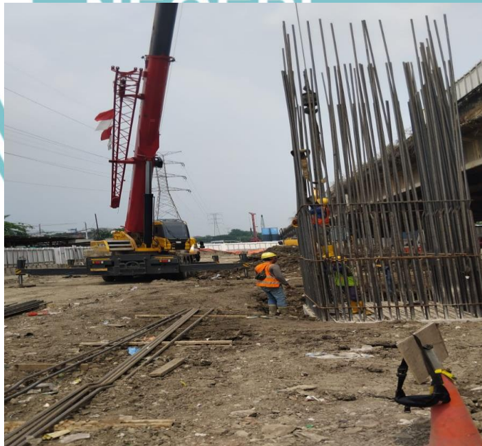
gambar 3.23 pabrikasi tulangan pilar stage 2
