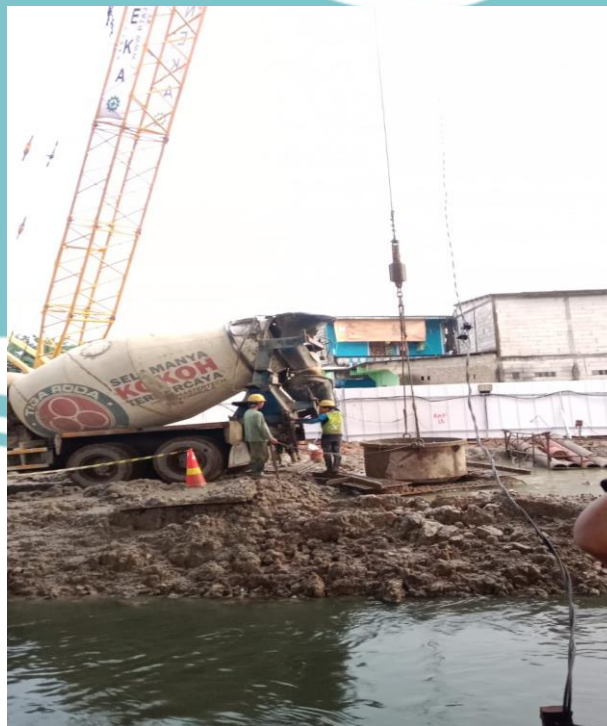
Gambar 3.11 pengecoran borepile Sumber : dokumen penulis, 2024
