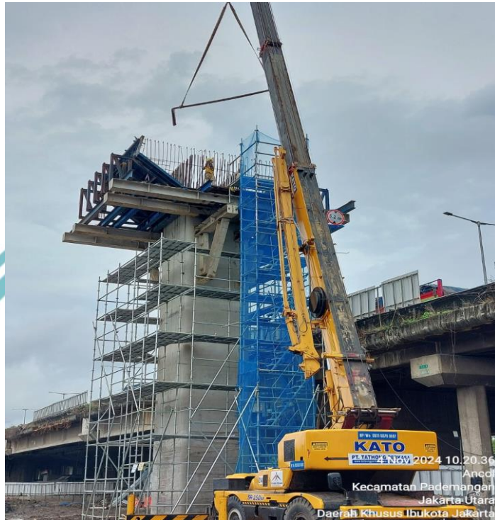
Gambar 3.31 pemasangan bekisting pada pier head
