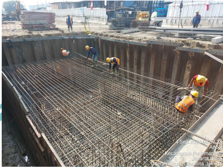
Pada Gambar 3.19 pembesian tulangan
