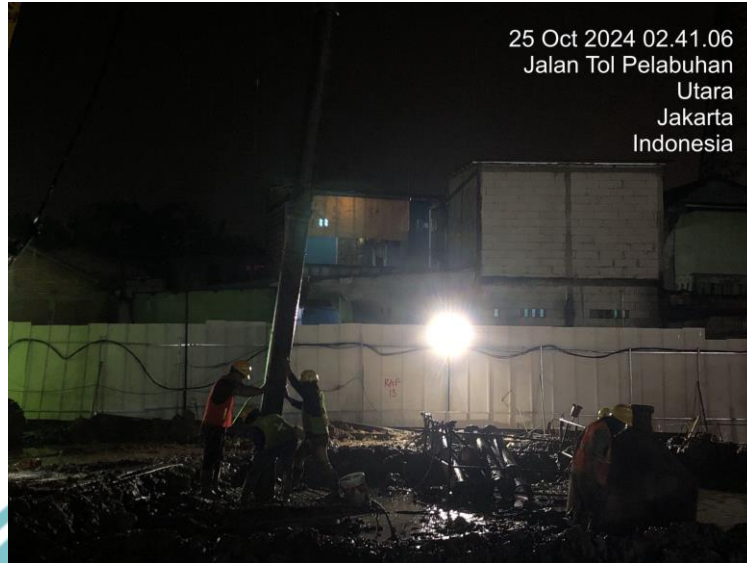
Gambar 3.10 pemasangan pipa tremie Sumber : dokumen penulis, 2024
