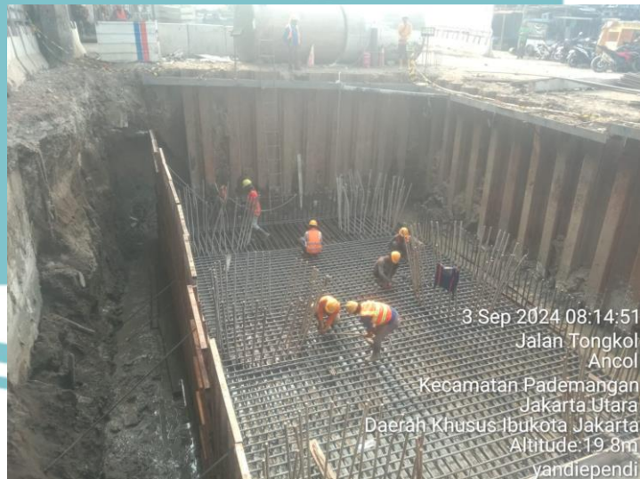
Pada Gambar 3.17 pengecoran lantai kerja
