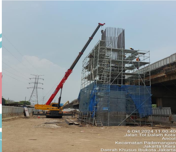
gambar 3.24 pabriksi tulangan pilar stage 3
