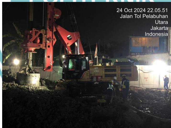
Gambar 3.8 pembersihan lubang borepile
