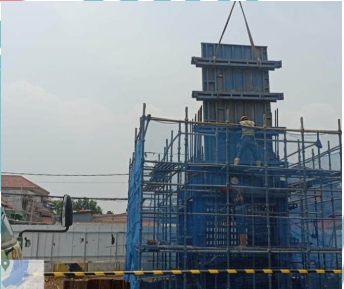
Gambar install 3.26 bekisting pada pier
