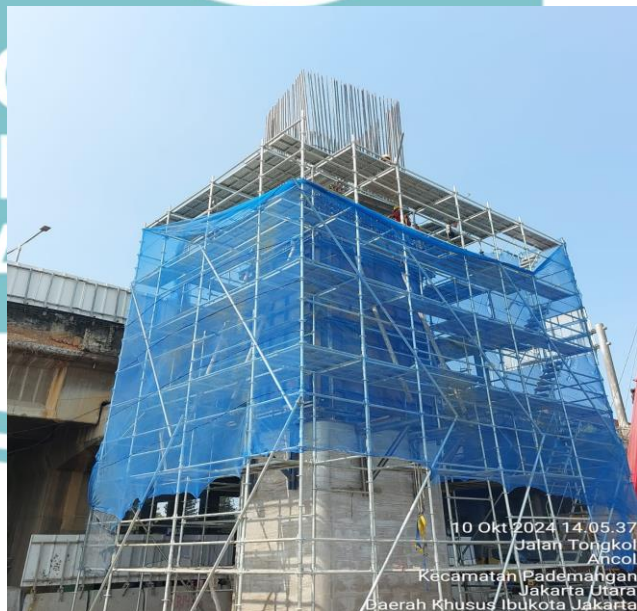
gambar 3.25 pabriksi tulangan pilar stage 4
