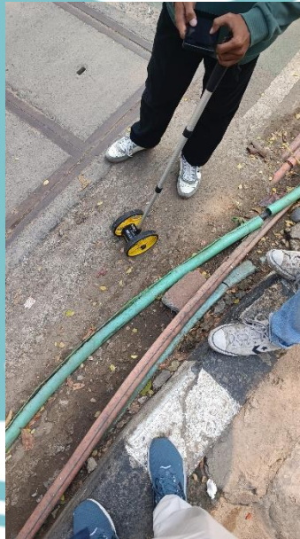
Gambar L. 2 Survey jalur kabel antar DC
