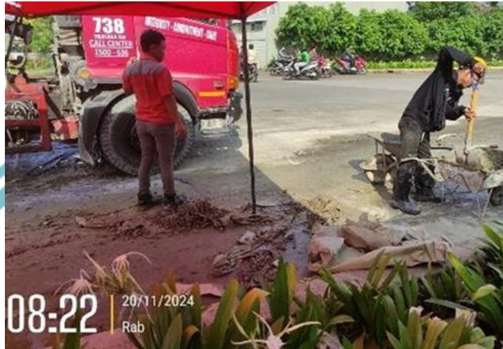
Gambar 3.56 Monitoring Pembersihan Beton Limbah Pengecoran
