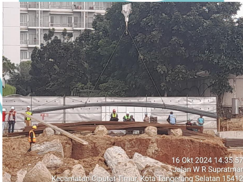
Gambar 3.37 Pemindahan Besi menggunakan Tower Crane
