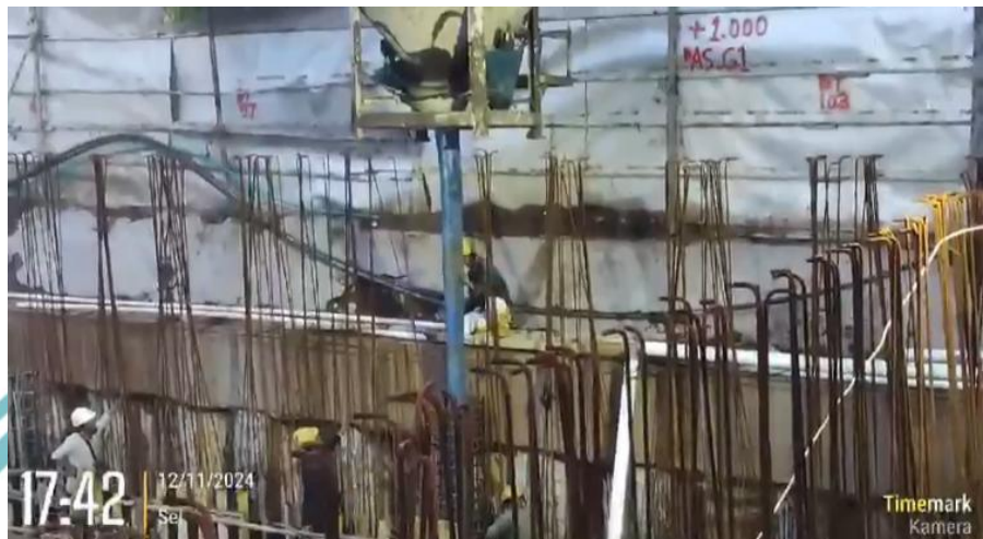
Gambar 3.18 Pekerjaan Pengecoran Retaining Wall
