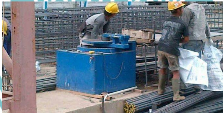
Gambar 3.35 Pemotongan Besi dengan Bar Cutter
