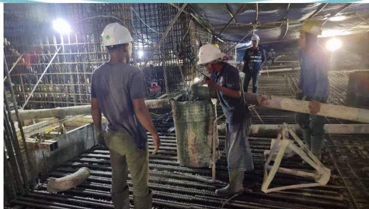
Gambar 3.41 Penggunaan Vibrator Pondasi Raft
