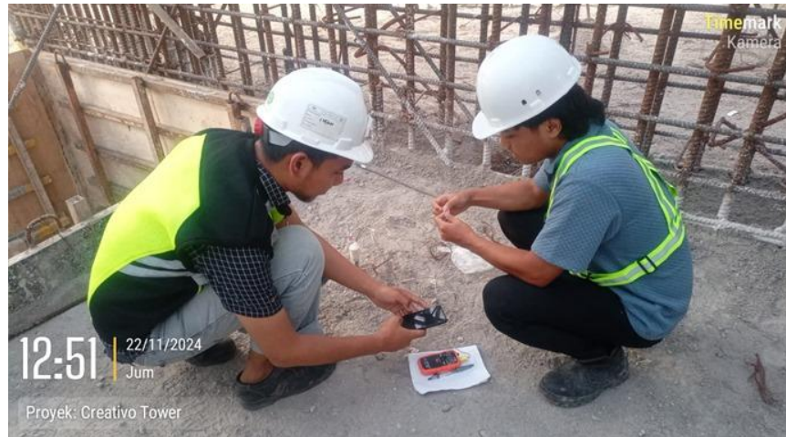
Gambar 3.43 Pengecekan Suhu
