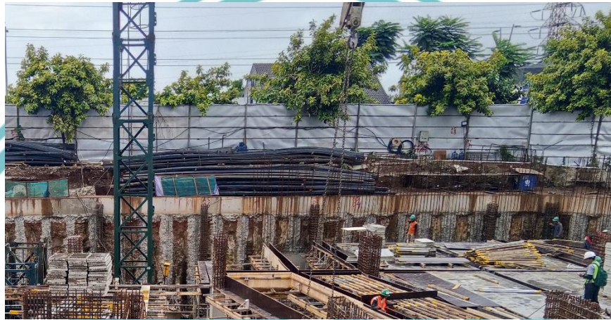
Gambar 3.34 Letak Penyimpanan Besi Pondasi Raft
