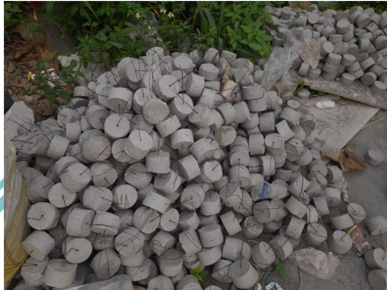
Gambar 3.31 Pekerjaan Persiapan Pondasi Raft
