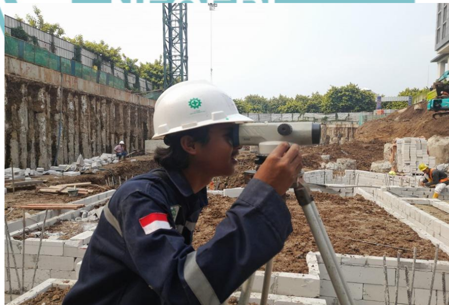
Gambar 3.15 Pekerjaan Persiapan Retaining Wall
