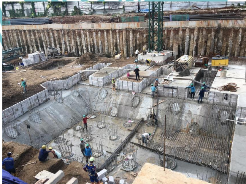
Gambar 3.33 Pekerjaan Lantai Kerja
