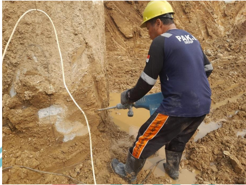
Gambar 3.32 Pembongkaran Bored Pile
