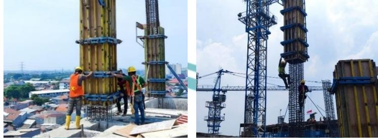
Gambar 3. 59 Pekerjaan Pemasangan Bekisting Kolom
