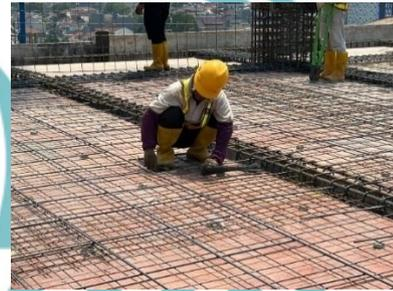
Gambar 3. 53 Pekerjaan Penulangan Plat Lantai
