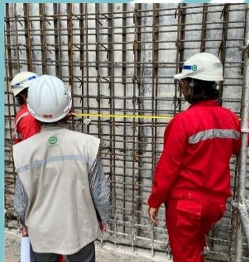
Gambar 3. 24 Checklist Pekerjaan Pembesian Dinding
