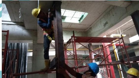
Gambar 3. 18 Pemasangan Angkur M16 Bagian Atas
