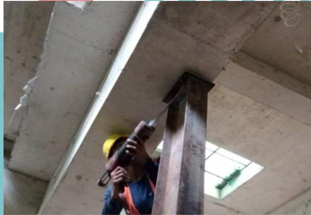
Gambar 3. 16 Injeksi Chemical dan Pemasangan Angkur Bagian Atas
