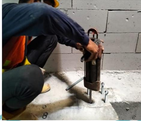
Gambar 3. 15 Injeksi Chemical dan Pemasangan Angkur Bagian Bawah
