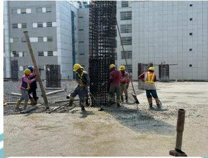
Gambar 3. 54 Pekerjaan Pengecoran Balok dan Plat Lantai
