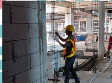
Gambar 3. 64 Pekerjaan Pemasangan Kolom Praktis
