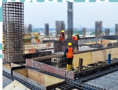
Gambar 3. 51 Pekerjaan Bekisting Balok dan Plat Lantai
