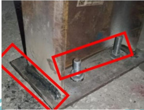
Gambar 3. 20 Area Sambungan Baja yang Di Las
