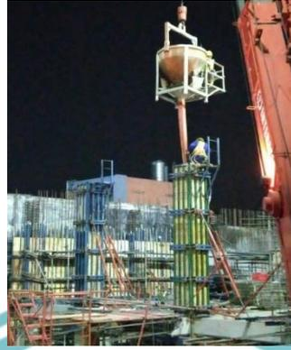
Gambar 3. 60 Pekerjaan Pengecoran Kolom
