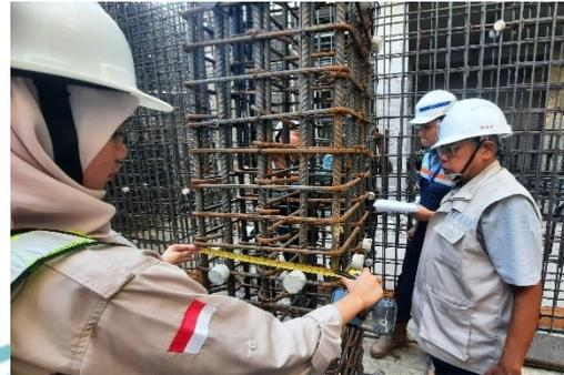
Gambar 3. 26 Checklist Pekerjaan Pembesian Kolom
