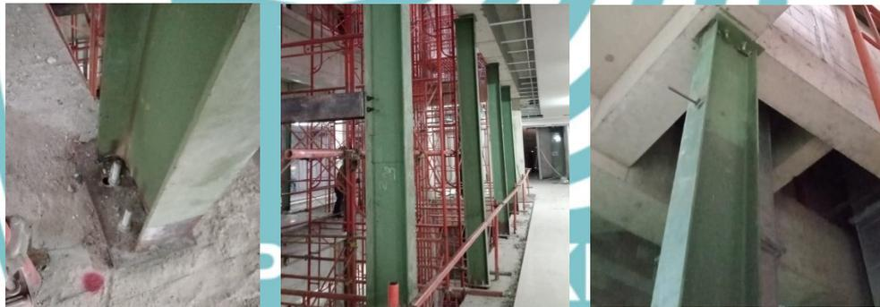
Gambar 3. 21 Kolom Lift Baja Gedung Pelayanan
