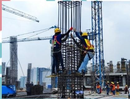
Gambar 3. 58 Pekerjaan Penyambungan Tulangan Kolom
