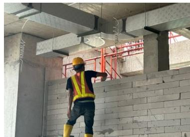
Gambar 3. 63 Pekerjaan Pemasangan Bata Ringan
