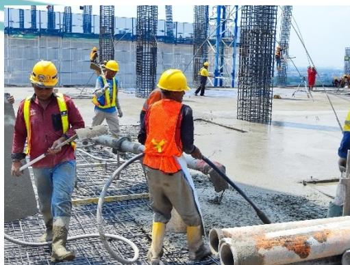
Gambar 3. 32 Proses Pengecoran Balok dan Plat Lantai
