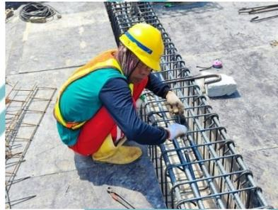
Gambar 3. 52 Pekerjaan Penulangan Balok
