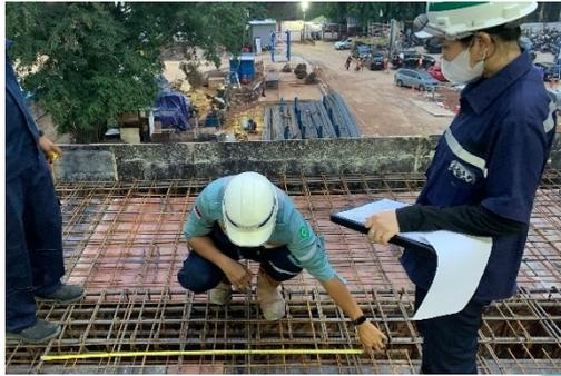
Gambar 3. 25 Checklist Pekerjaan pembesian Balok
