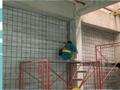
Gambar 3. 65 Pekerjaan Pemasangan Wiremesh Dinding Confinement
