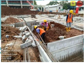
Gambar 3. 23 Pekerjaan Bekisting Tie Beam
