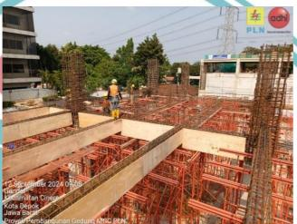
Gambar 3. 45 Pemasangan Bekisting Balok
