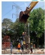
Gambar 3. 72 pengujian PIT dan PDA
