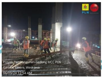
Gambar 3. 46 Pengecoran Balok
