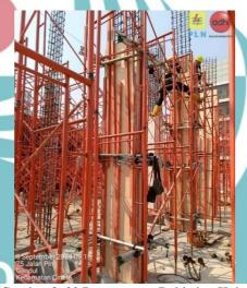
Gambar 3. 30 Pemasangan Bekisting Kolom
