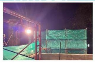
Gambar 3. 7 Safety net pada bangunan Intermediate lantai 1
