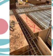
Gambar 3. 58 pengecekan pembesian balok
