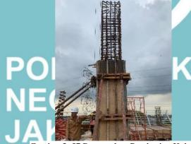
Gambar 3. 57 Pengecekan Pembesian Kolom
