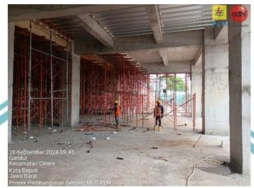
Gambar 3. 39 Pembongkaran Bekisting
