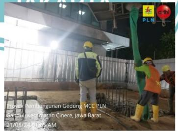
Gambar 3. 25 Pengecoran Pile Cap & Tie Beam
