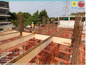
Gambar 3. 37 Pemasangan Bekisting
