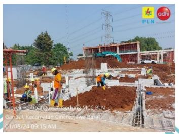
Gambar 3. 22 Pekerjaan Urugan Pasir & Lantai Kerja
