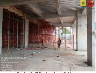
Gambar 3. 47 Pembongkaran Bekisting
