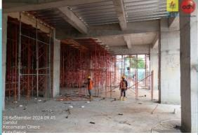
Gambar 3. 32 Pembongkaran Bekisting
