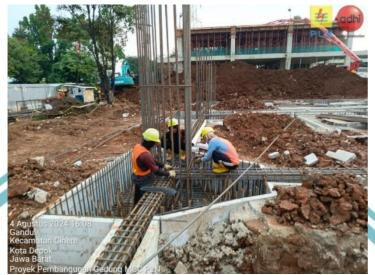
Gambar 3. 24 Pekerjaan Pembesian Tie Beam
