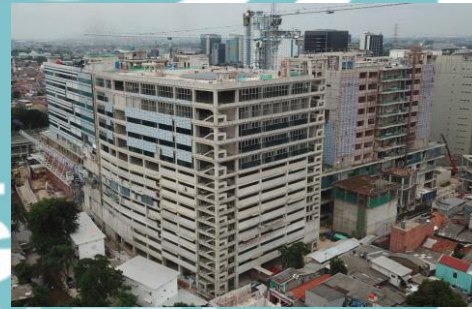
Gambar 3. 58 Tampak Belakang Samping Kiri View Drone Progres Gedung Pelayanan dan Parkir M-52
