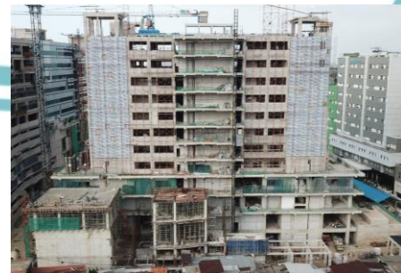
Gambar 3. 60 Tampak Belakang View Drone Progres Gedung Pendidikan M-52
