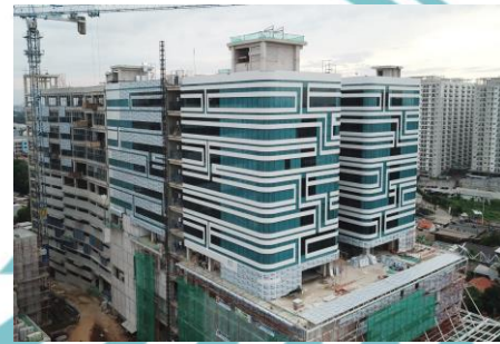
Gambar 3. 56 Tampak Depan Kiri View Drone Progres Gedung Pelayanan dan Parkir M-52
