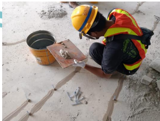
Gambar 3. 37 Proses Injeksi Struktur Beton
