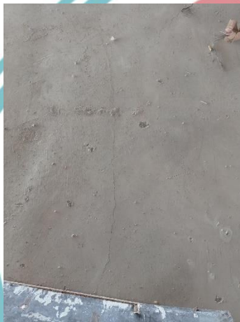
Gambar 3. 35 Retak Area Pelat
