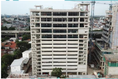
Gambar 3. 57 Tampak Belakang View Drone Progres Gedung Pelayanan dan Parkir M-52
