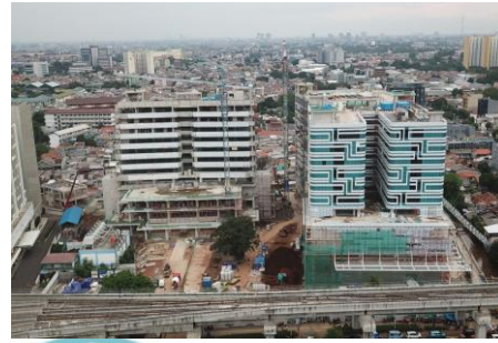
Gambar 3. 54 Tampak Depan View Drone Progres Proyek M-52
