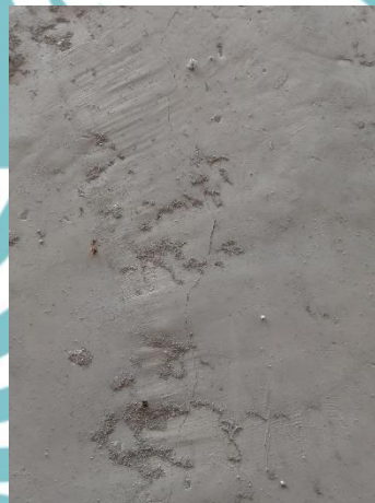
Gambar 3. 36 Retak Sepanjang Balok Anak
