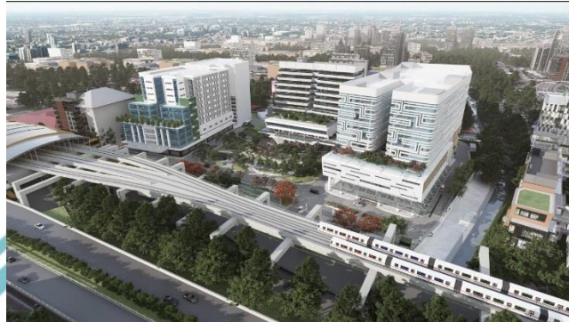
Gambar 3. 1 Proyek Pembangunan RS PON
