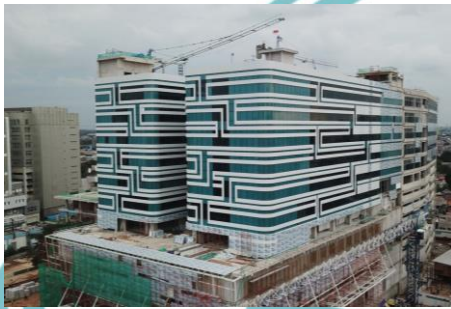
Gambar 3. 55 Tampak Depan Kanan View Drone Progres Gedung Pelayanan dan Parkir M-52
