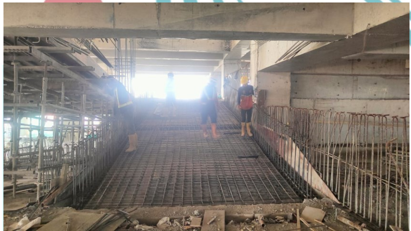
Gambar 3. 61 Pekerjaan Pembesian Ramp
