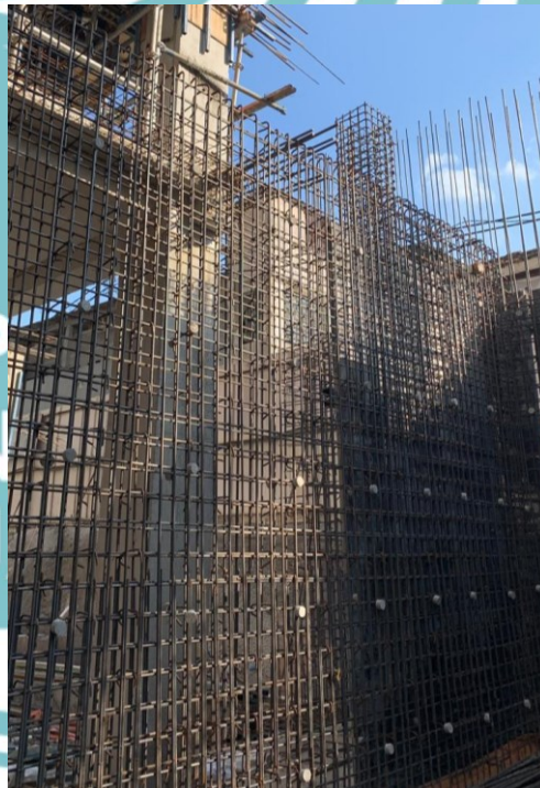
Gambar 3. 42 Pekerjaan Pembesian Retaining Wall
