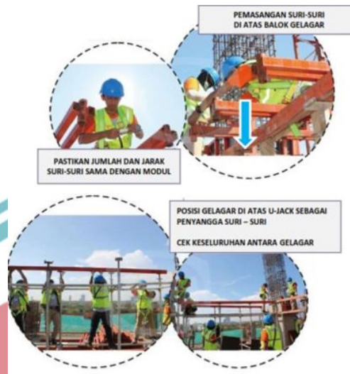
Gambar 3. 46 Urutan Pemasangan Gelagar dan Suri - suri
