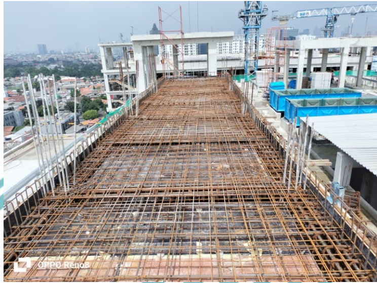
Gambar 3. 49 Pekerjaan Pembesian Balok dan Plat Lantai
