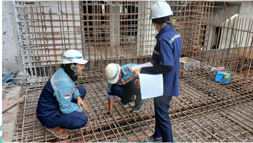
Gambar 3. 23 Kegiatan Checklist Pekerjaan Pembesian
