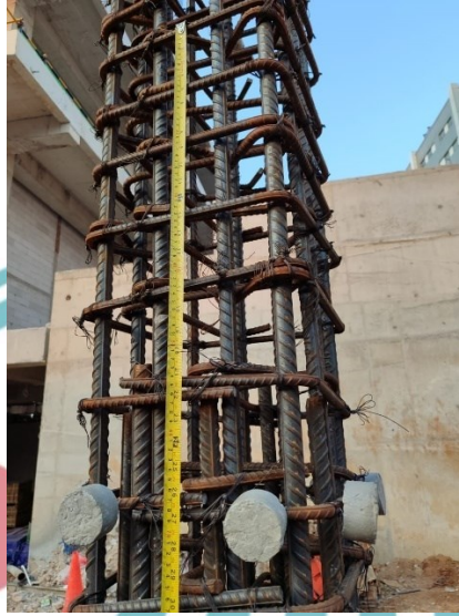
Gambar 3. 41 Pekerjaan Pembesian Kolom
