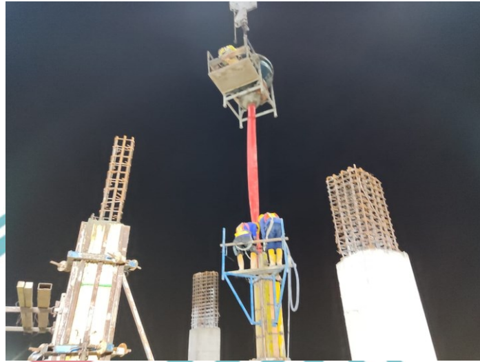
Gambar 3. 43 Pekerjaan Pengecoran Kolom
