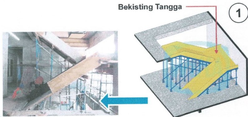
Gambar 3. 54 Pemasangan bekisting Tangga
