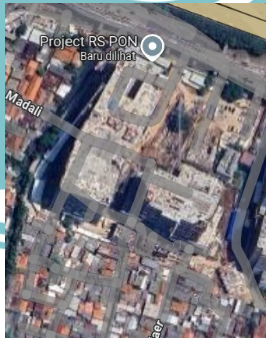
Gambar 3. 4 Batas Selatan Proyek Pembangunan Gedung RSPON
