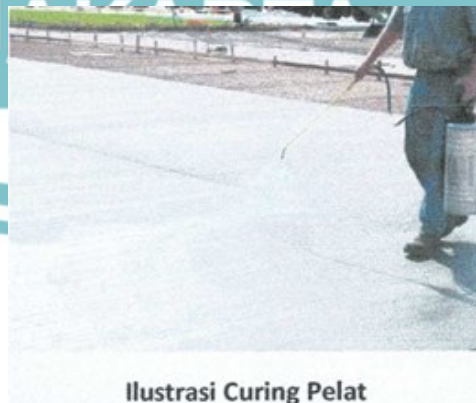
Gambar 3. 52 Pelaksanaan Curing Beton
