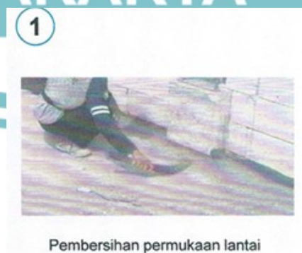
Gambar 3. 70 Pekerjaan Persiapan untuk Waterproofing
