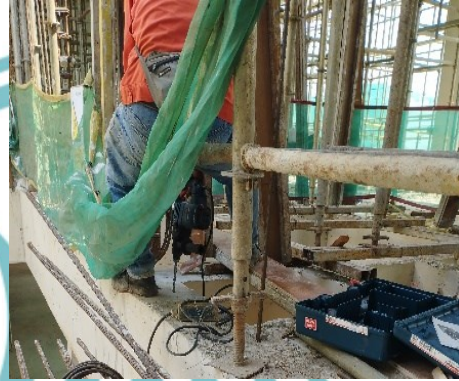
(Proses pengeboran titik marking )
