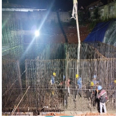
(pengecoran area STP)
