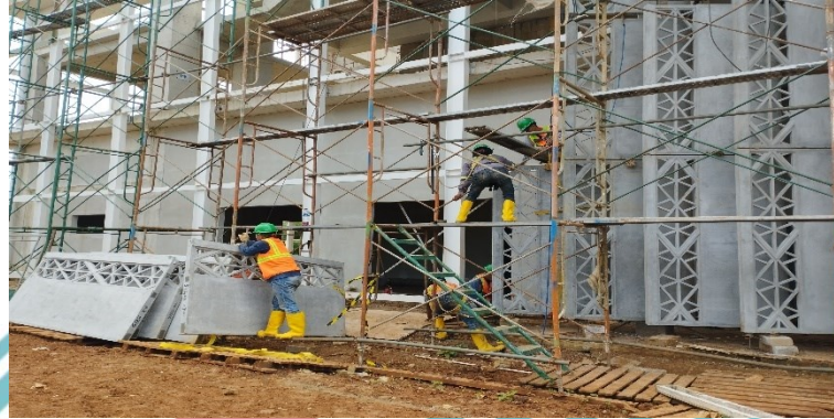
(Pemasangan GRC fasad)
