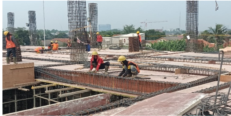
(pengerjaan tulangan dan bekisting balok)
