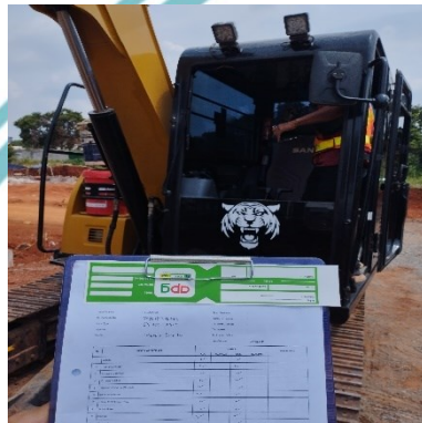
(Inspeksi peralatan excavator)
