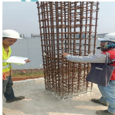
(Inspeksi tulangan pada kolom)
