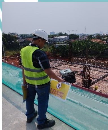
(Pemasangan rambu keselamatan)
