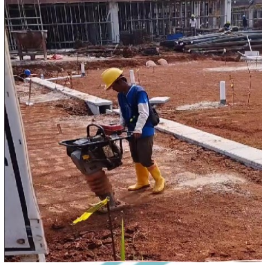
(Pemadatan tanah untuk area ruang terbuka)
