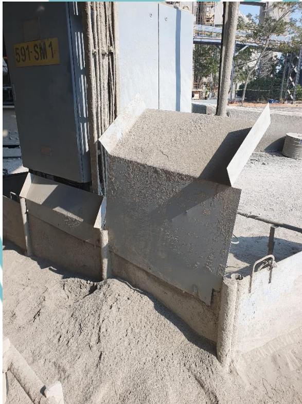
Lampiran 7 Penambahan Expansion Frame pada Autosampler 591-SM1
