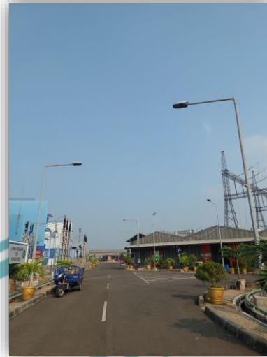
Gambar 1.2 Penerangan Jalan di Area Blok 3
