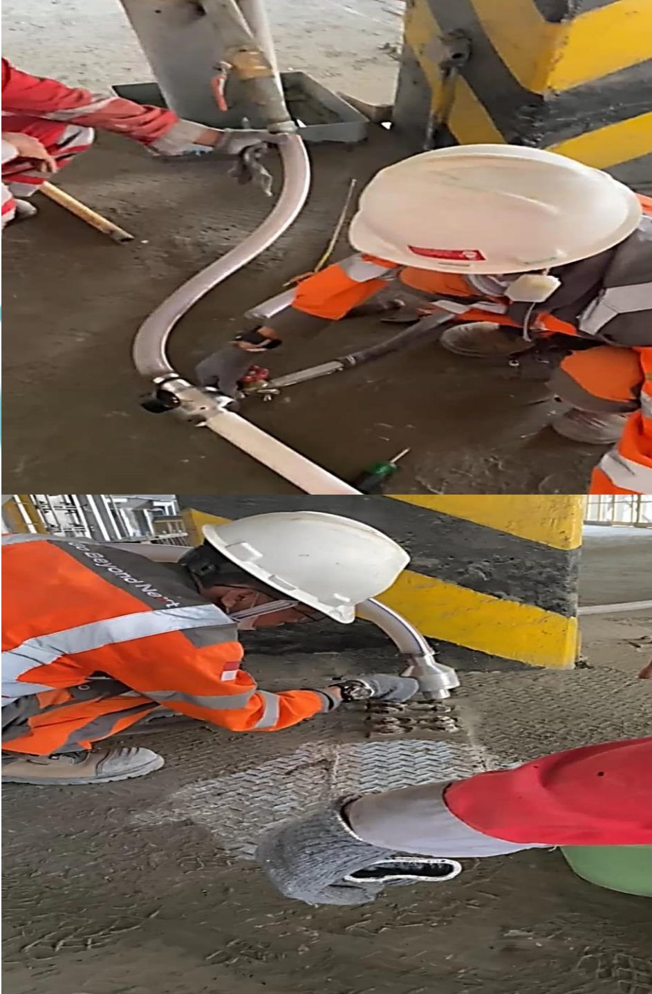
Lampiran 9 : Simulasi ke-2 menggunakan inlet PVC 10[cm] dan tanpa PVC di 473-GQ1 Raw Mill Nar 1
