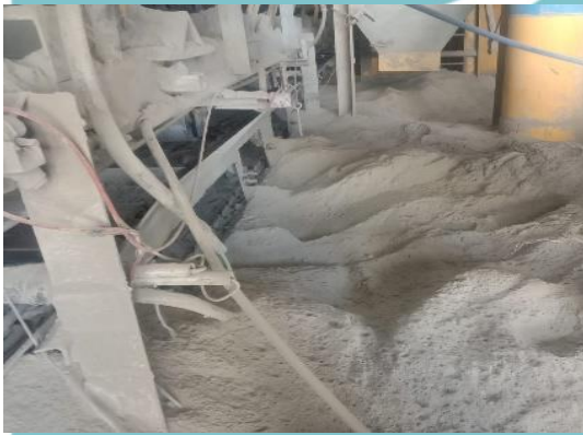
Gambar 1.3 Debu Clinker yang Terbuang pada Belt Conveyor 532-BC3
