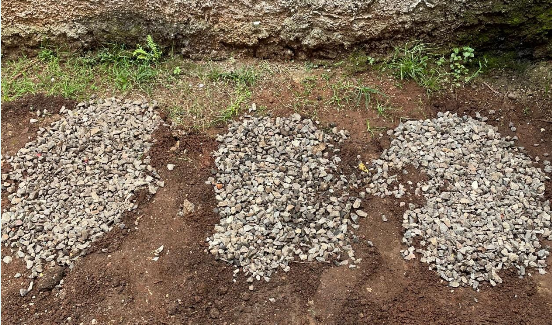
Lampiran 5 Penguburan Anoda Korban menggunakan Batu
