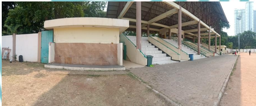
Gambar 4.2 Dokumentasi Area Lapangan Bola (Tribun, Tempat Cuci Kaki & Toilet)
