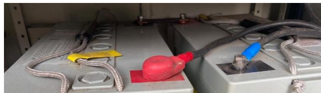
Gambar 2. tidak ada tanda korosi
