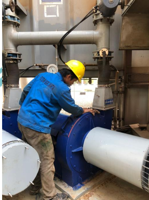
Lampiran 1. Kegiatan Preventive Maintenance Pada Seal Air Fan
