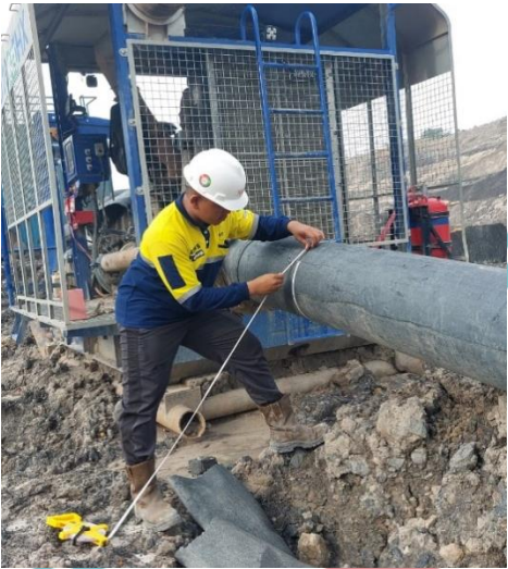
Pemasangan pipa HDPE
