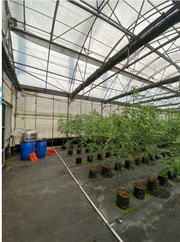
(L-1) Kondisi Greenhouse
