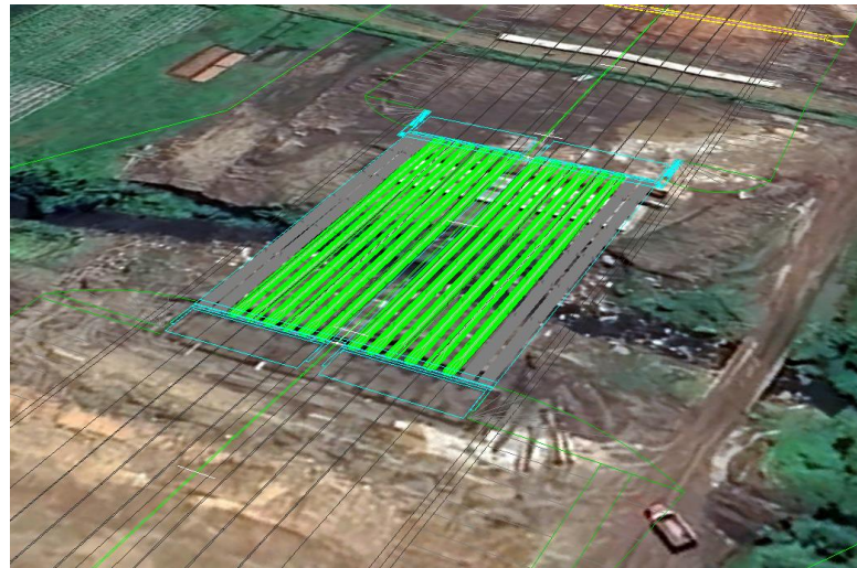
Gambar 4.2.4. 2 Lokasi Erection PC-I Girder Jembatan Lusuh STA 29+568
