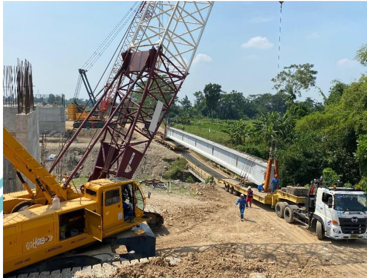
Gambar 4.2.4. 6 PCI Girder Bergerak ke Lokasi Erection dengan Bogie Truck
