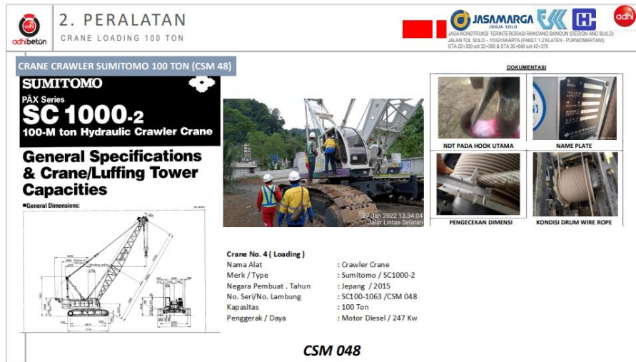
Gambar 4.2.2. 3 Crawler Crane 100 Ton
