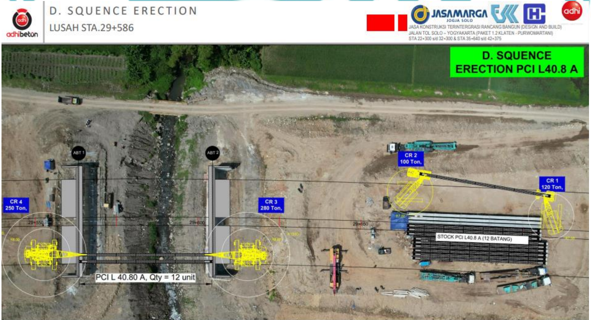
Gambar 4.2.4. 11 Proses Erection dan Peletakan Bearing Pad Pada Girder Ke-dua
