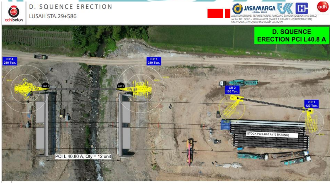
Gambar 4.2.4. 9 Proses Erection PCI Girder Pertama
