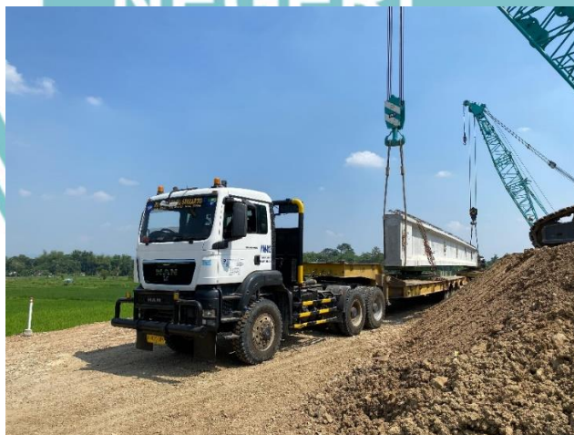
Gambar 4.2.4. 5 Proses Pengangkatan Girder ke Bogie
