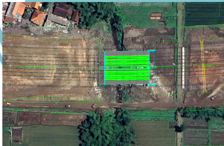
Gambar 4.2.4. 1 Lokasi Erection PC-I Girder Jembatan Lusah STA 29+568
