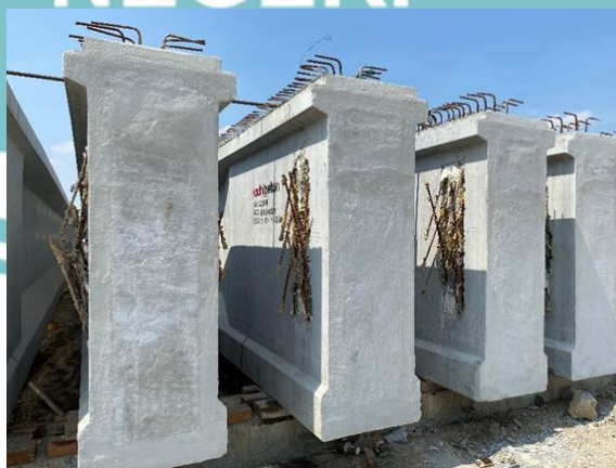
Gambar 2.3. 1 Girder Tipe PC-I
