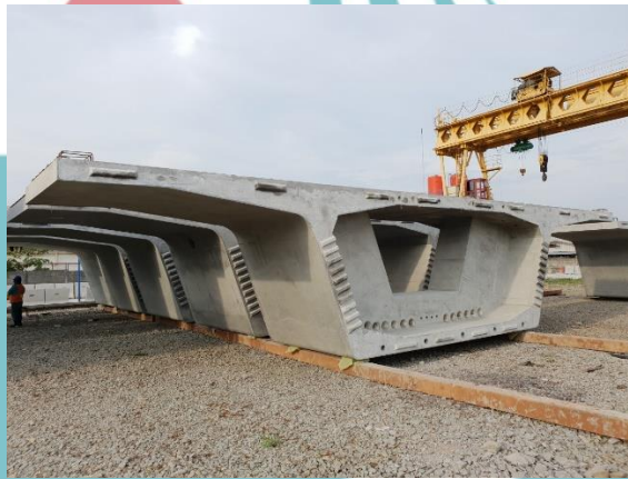
Gambar 2.3. 2 Girder Tipe Box
