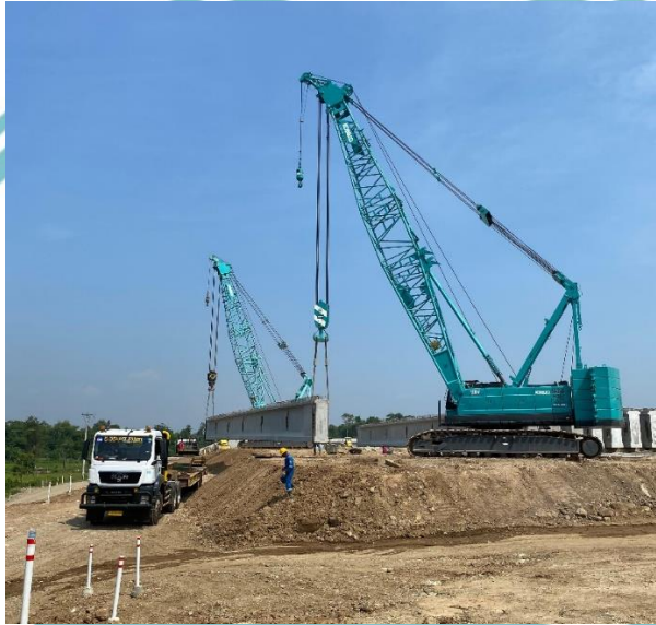
Gambar 4.2.4. 4 Proses Pengangkatan Girder ke Bogie
