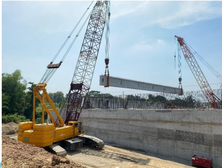
Gambar 4.2.4. 7 Memposisikan Girder ke Bearing Pad
