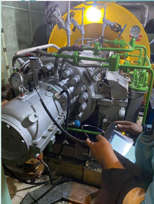
Pengambilan nilai vibrasi Horizontal
