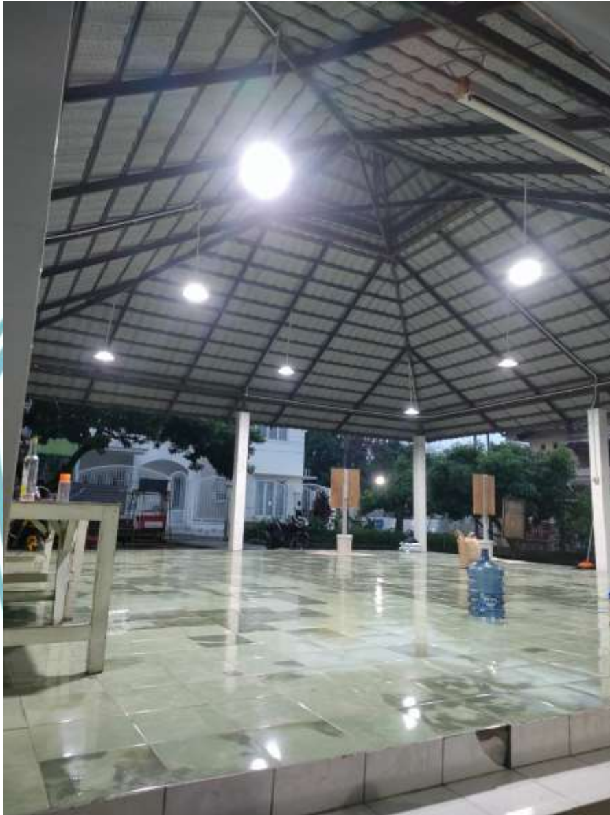
Lampiran 4 Kondisi Pendopo Balai RW 03 Beji Timur Setelah Dilakukan Perbaikan dan Pemasangan Sistem
