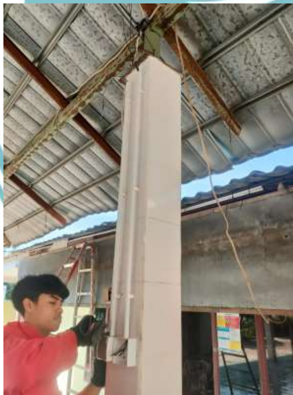
Lampiran 3 Kegiatan Pemasangan Instalasi pada Pendopo Balai RW 03 Beji Timur
