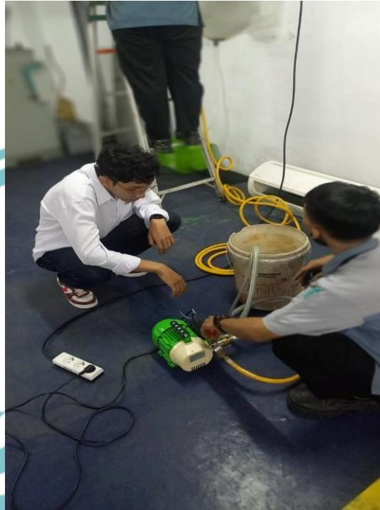
Perbaikan Motor Coupling CHWP
