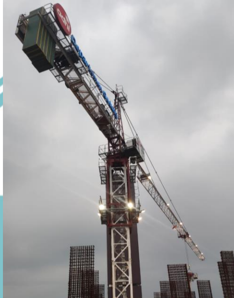
Gambar 4. 22. Tower Crane Sumber: Dokumen Pribadi
