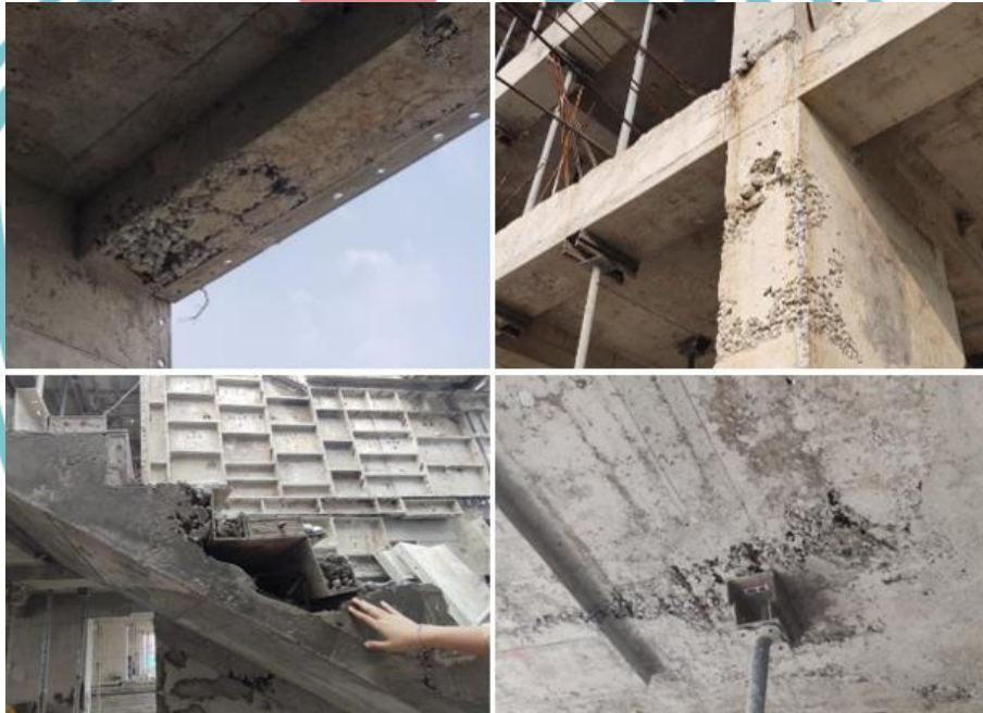
Gambar 4. 17. Deffect Pada Elemen Struktur Sumber: Dokumen Pribadi
