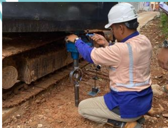
Gambar 4. 9. Tes CBR Lapangan Sumber: Dokumen Pribadi
