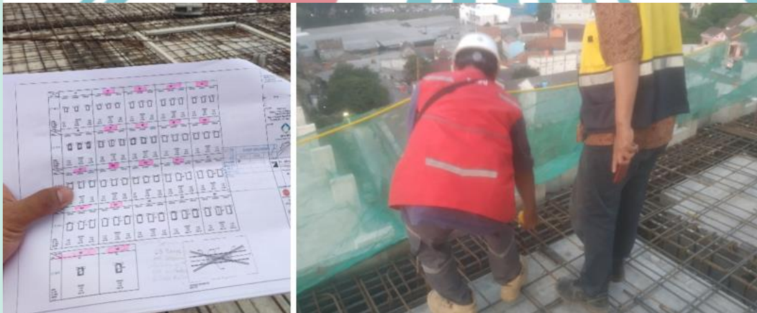
Gambar 4. 12. Pemeriksaan Pembesian Balok Sumber: Dokumen Pribadi
