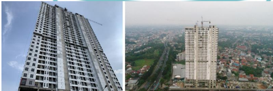
Gambar 3. 3 Tampak Depan Proyek Rusun Mahata Serpong Sumber: Dokumen PT. Artefak Arkindo
