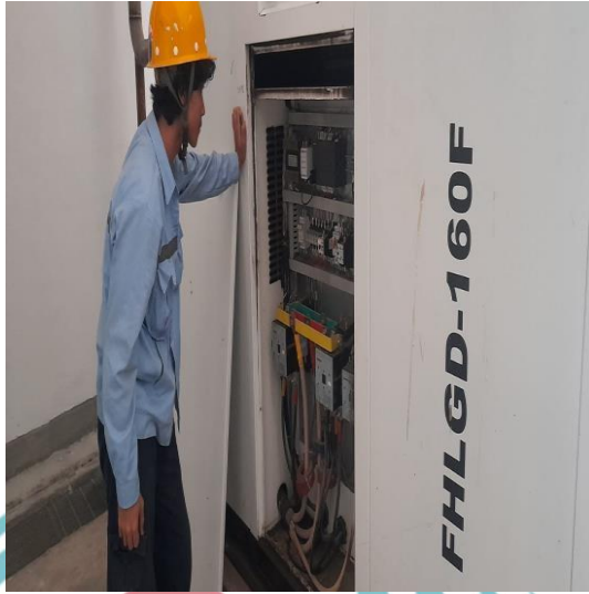
Gambar Lampiran 1 Inspeksi Kompresor
