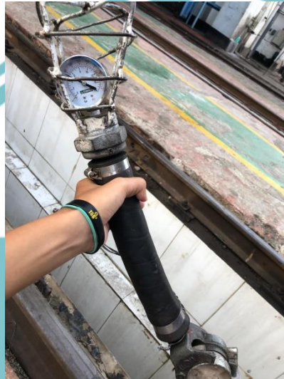
Gambar 3.15 Pengukuran Tekanan Angin Pengereman dengan Manometer
