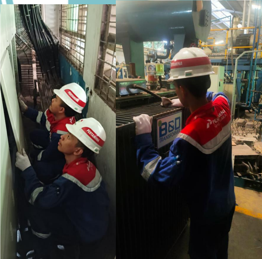
Pekerjaan di PT. Priscolin Karawang
