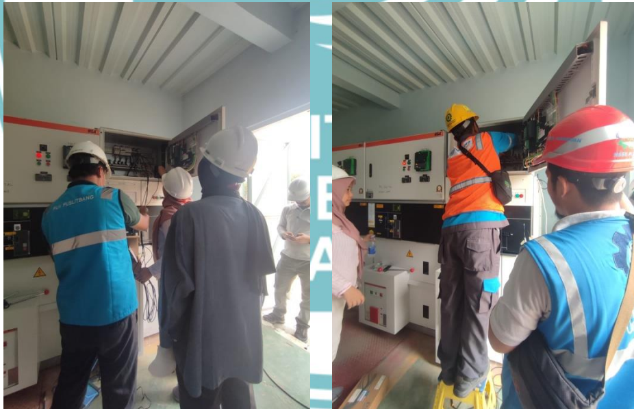
Gambar kegiatan power quality measurement pada gardu PLN Karawang (Sumber: Dokumentasi Pribadi)
