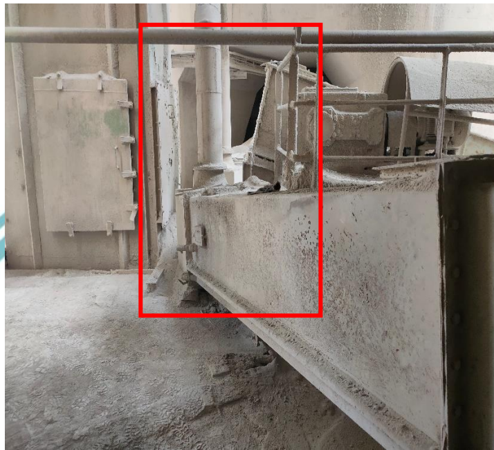
LAMPIRAN 3 Sebelum dan sesudah pemasangan Cut Off Damper di 312-AS15
