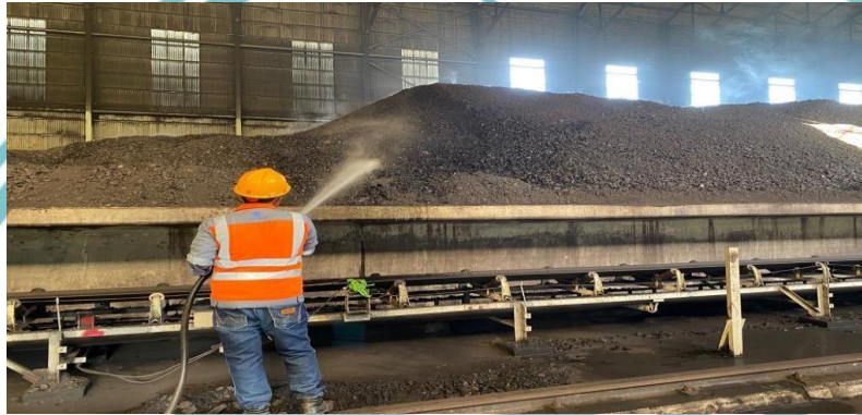
Gambar 2.3.2 sistem penyemprotan hydrant
