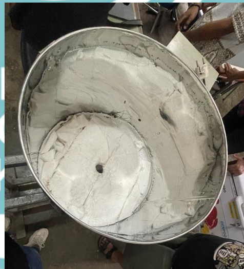
Proses pemasangan lapisan isolator pada dandang oven
