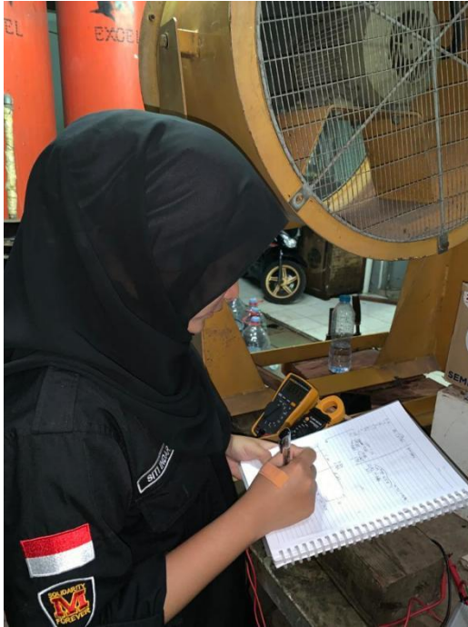
Pengukuran daya yang keluar pada generator
