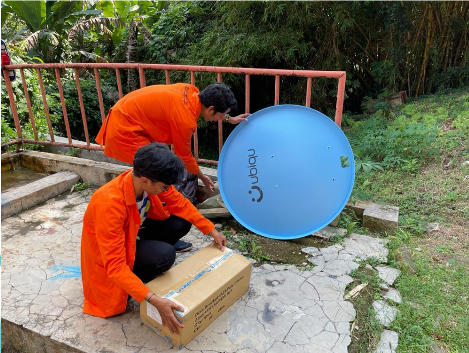
Proses pemasangan antenna VSAT.
