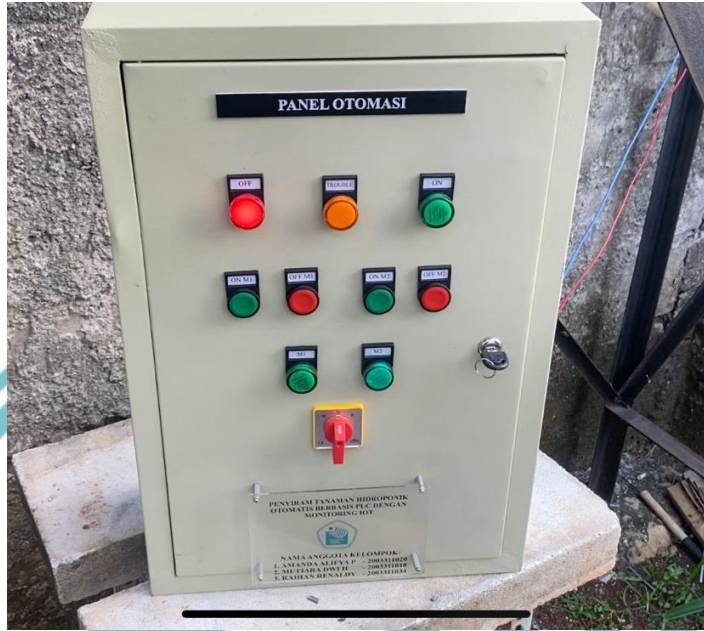
Lampiran 1. 1 Panel Sistem Penyiraman Otomatis
