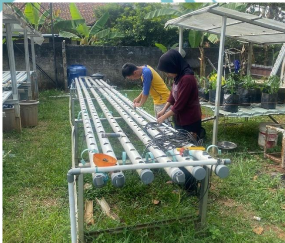
Lampiran 1. 7 Pemasangan Selang Drip Irigasi pada Pipa
