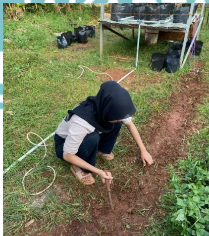
Lampiran 1. 5 Pembuatan Jalur Untuk Instalasi Pipa
