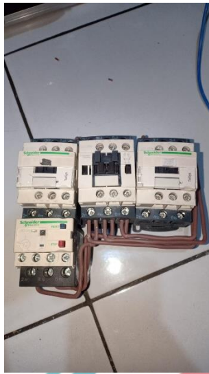
Proses pengkabelan daya
