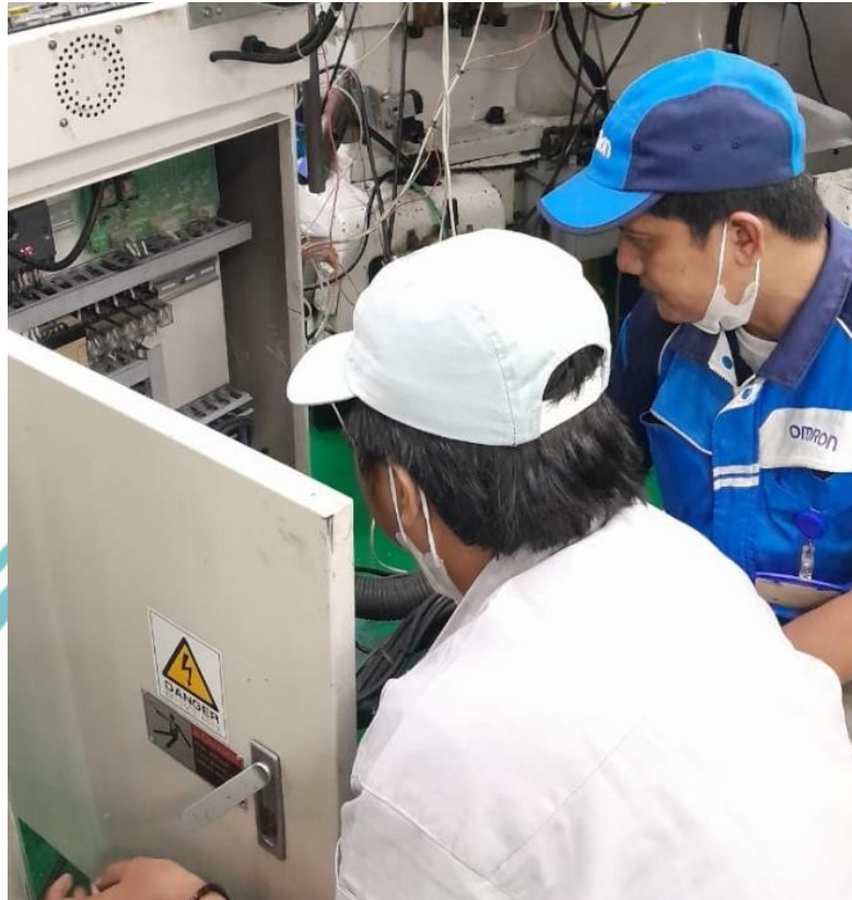
Gambar L- 1 Foto saat melakukan Wiring Relay
