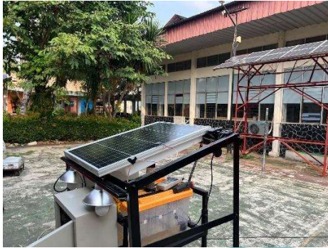
Pemasangan Sensor DHT22
