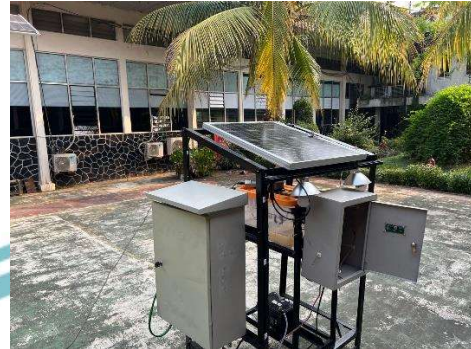
Pemasangan Pendingin pada Panel Surya
