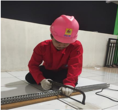
Pemotongan cabl duct
