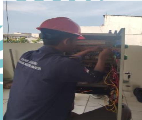
Pengkabelan ( wiring ) rangkaian kontrol
