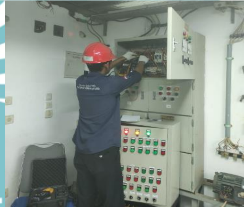
Pengukuran tegangan sebelum pengoperasian motor induksi
