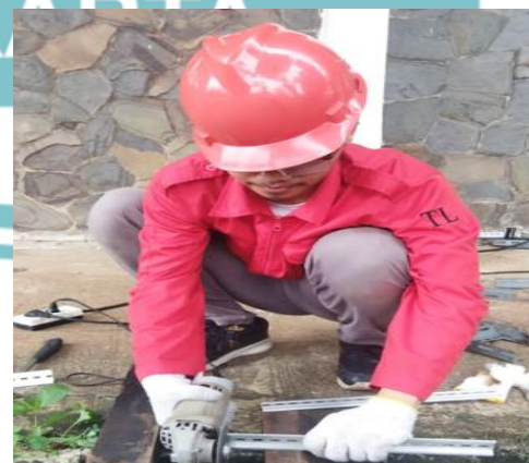
Pemotongan dinrail dan besi rangka
