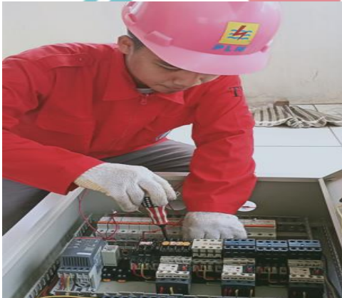
Pengkabelan ( wiring ) rangkaian daya
