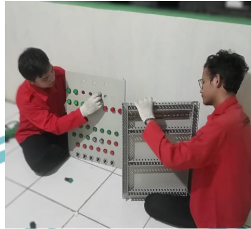
Pemasangan komponen pada pintu panel
