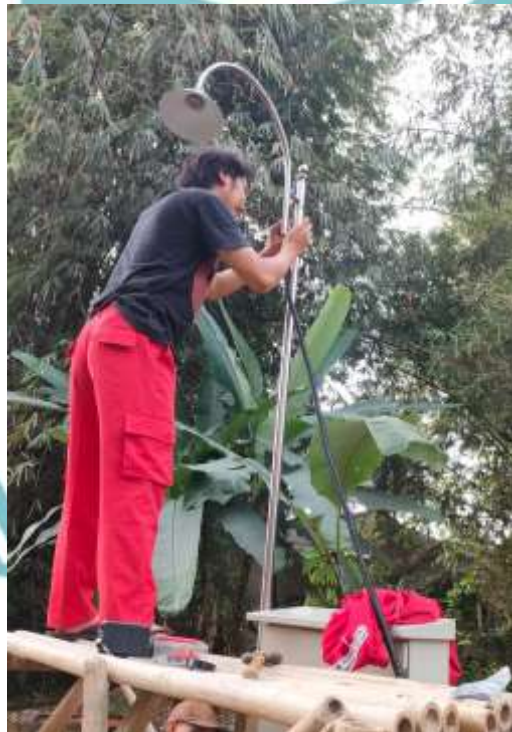
Pemasangan sensor LDR
