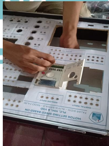
Proses pemasangan VSD
