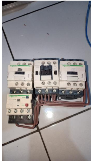
Proses pengkabelan daya
