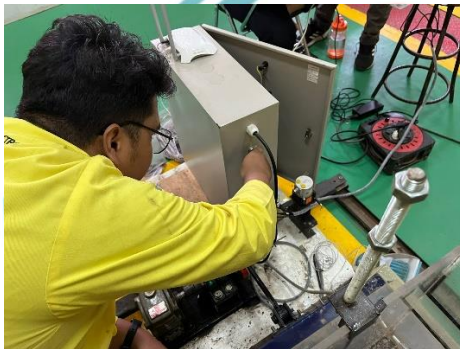
Dokumentasi saat melakukan pemasangan konektor dari sensor ke panel
