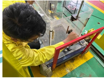
Dokumentasi saat melakukan pemasangan pressure transmitter
