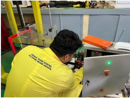
Dokumentasi saat cek wiring panel
